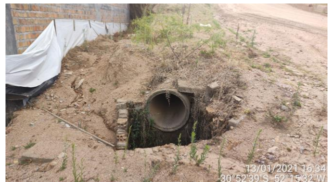
Figura 9 – Detalhe drenagem existente, próximo à estaca 0.
