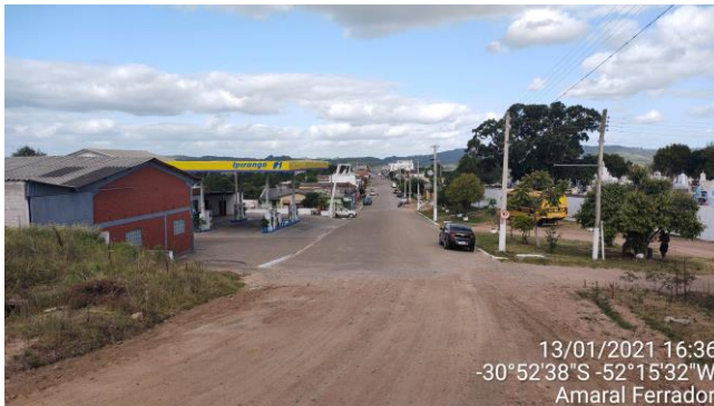
Figura 4 – Início de Trecho, estaca 0, Pavimento existente;
