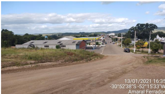
Figura 5 – Vista próximo à estaca 2;
